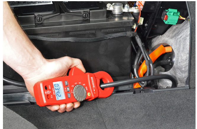
Ruhestrommessung an der Batterie zuleitung
